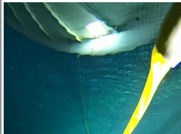
21) 00:02 Open roof hatch
