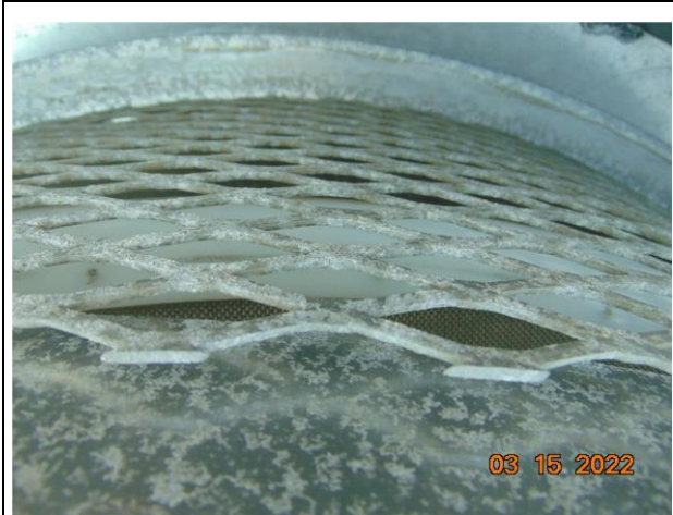
13) Intact vent screen
