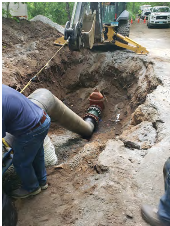
BYPASS REPAIR PHOTO 2 SCALE: N.T.S.
